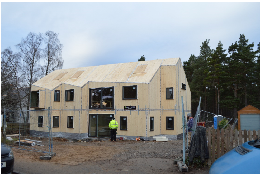
Figuur 1. CLT huis in aanbouw
