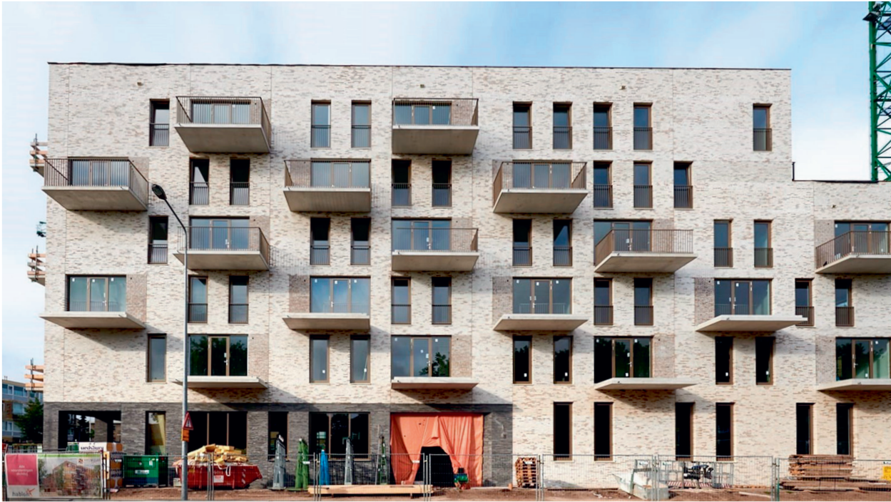
Alba gebouw in Hilversum, buitenaanzicht.
