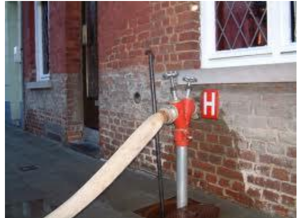
Figuur 7: Ondergrondse hydrant met opzetstuk.
