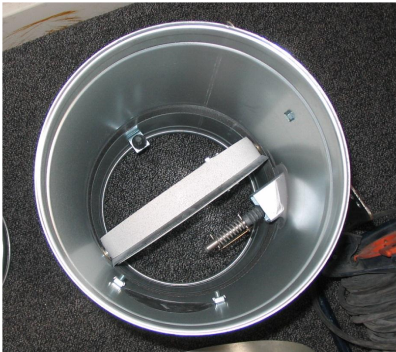
Figuur 17: Binnenzijde brandklep (in geopende toestand). In geval van brand zal de klep sluiten en wordt het kanaal afgedicht.
