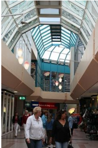
Figuur 3: Rook- en warmteafvoervoorzieningen in overdekte winkelstraten.
